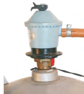
Tryckregulatorn när den är fastsatt på gasflaskan.
