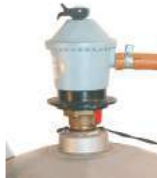
Paineensäädin kiinnitettynä kaasupulloon.
