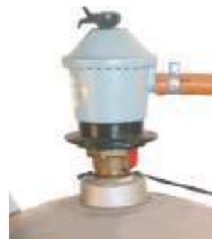
Paineensäädin kiinnitettynä kaasupulloon.
