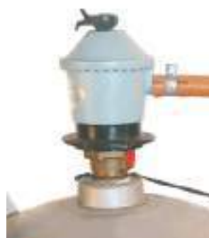
Tryckregulatorn när den är fastsatt på gasflaskan.
