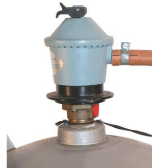
Paineensäädin kiinnitettynä kaasupulloon.
